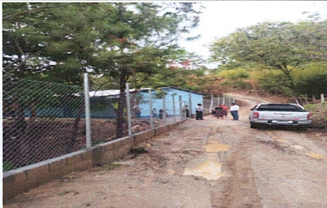
Foto 3: finalización muro perimetral
