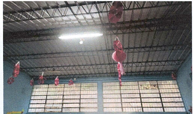
Finalización de sistema eléctrico
