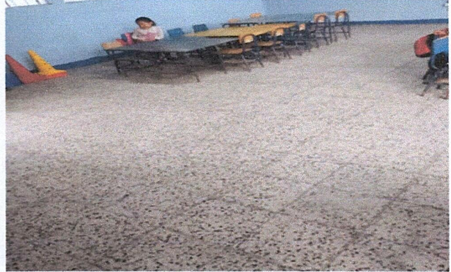
Foto 2: Finalización colocación piso aula preprimario
