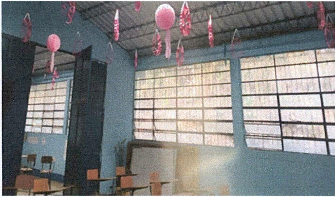
Foto 1: finalización de colocación de ventanas
